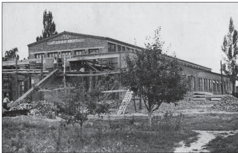
Закінчення будівництва майстерні для ремонту різної сільськогоспо- дарської техні- ки. Фото 1964 р.
