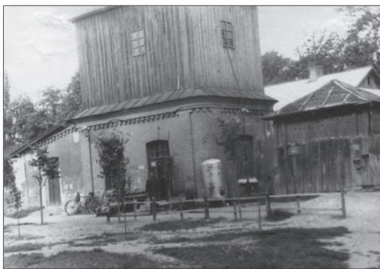
Приміщення панської водокачки побудованої у 1881 році. Фото 2001 р.
