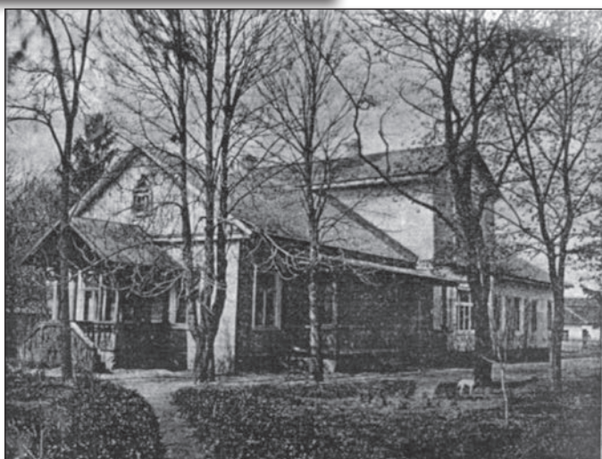
Будинок управління маєтку Балашових зі сторони центрального входу
