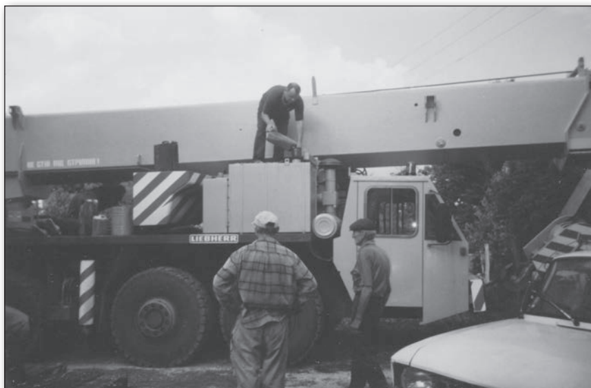
На будівельній площадці біля костелу могутній автокран
