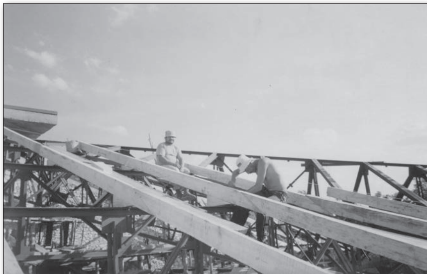
Монтаж і встановлення даху костелу проводять брати Залозні Микола і Віктор
