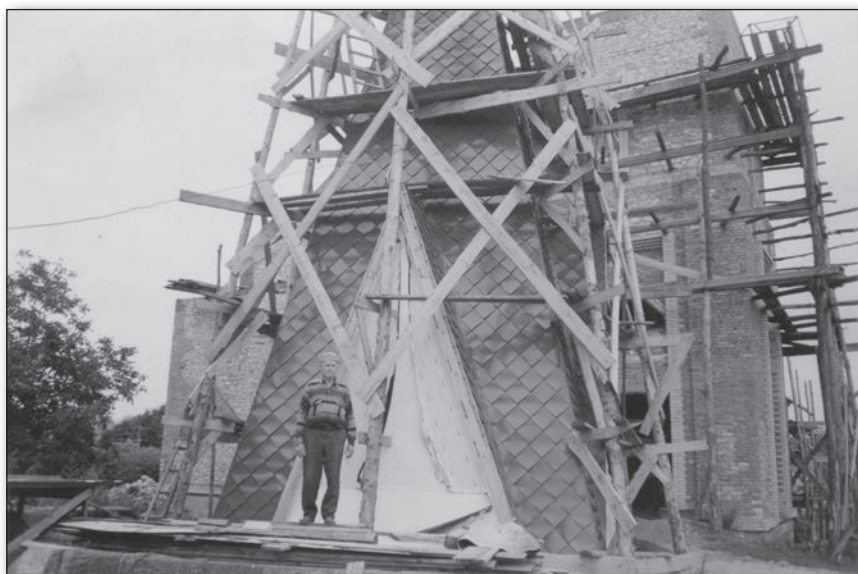
Монтаж костельної вежі
